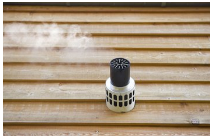
Det er en rigtig god idé at have god udluftning til badeværelset, så fugten, når du eksempelvis går i bad, kan komme ud af rummet. Foto: Torben Klint
